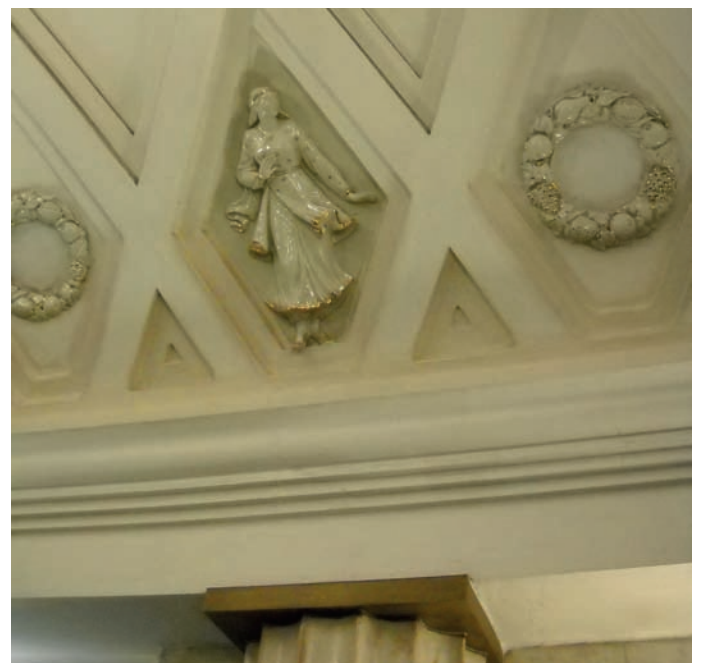
Teatrainaiia conçue par Ivan Fomine comme un foyer de théâtre donne accès au Bolchoï, ligne 2, 1938.
